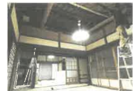
居間の天井を解体
