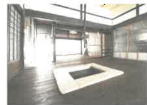
掘りだつたから囲炉裏へ改修
