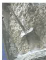
本漆喰練り (混ぜ合わせた状態)
