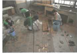
床タイル張り
