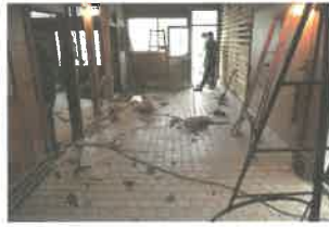
オフィスarea解体
