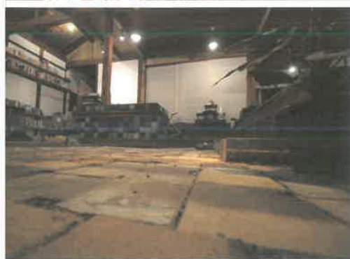
上: かまどのある土間 / 下: 耐火煉瓦の土間
