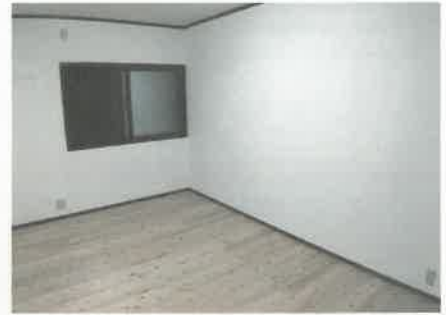
改修後の洋間(しっくい壁・無垢床)
