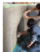
モルタル洗い出し
