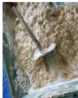
本漆喰練り (混ぜ合わせた状態)
