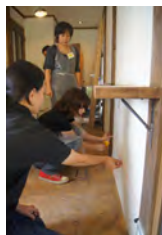
タイル墨出し
